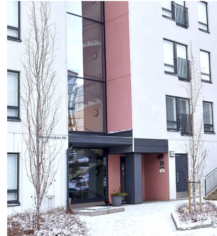
Sisäänkäynti ja porrashuone syvennyksessä. Kuva: Tampereen kaupunki.
