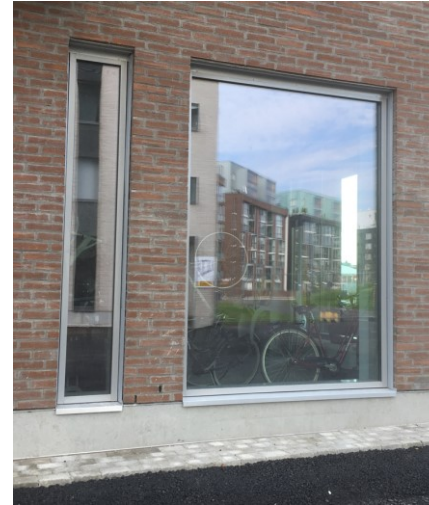
Ikkunallinen pyörävarasto katujulkisivussa. Kuva: Tampereen kaupunki.
