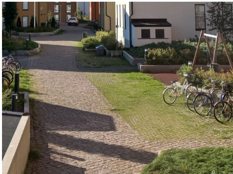
Vettä läpäiseviä pintamateriaaleja. Kuva: Tampereen kaupunki.
