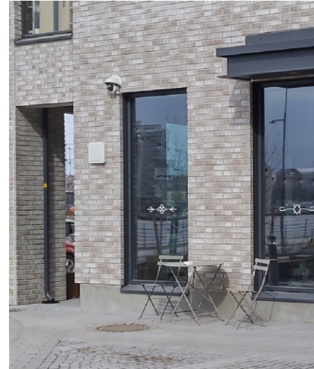
Aukio ja katutaso liiketila. Kuva: Tampereen kaupunki.
